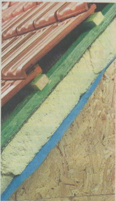
Lohnt sich Dämmen überhaupt? Eine Studie im Auftrag der Förderbank KfW kommt zu einem ernüchternden Ergebnis.
